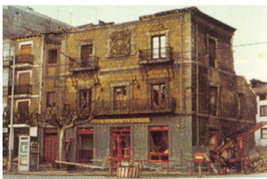
Casa de la Matra antes de su derribo.
