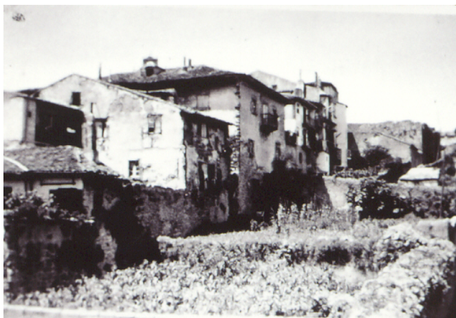
Traseras de las casas de la calle de Santa María
