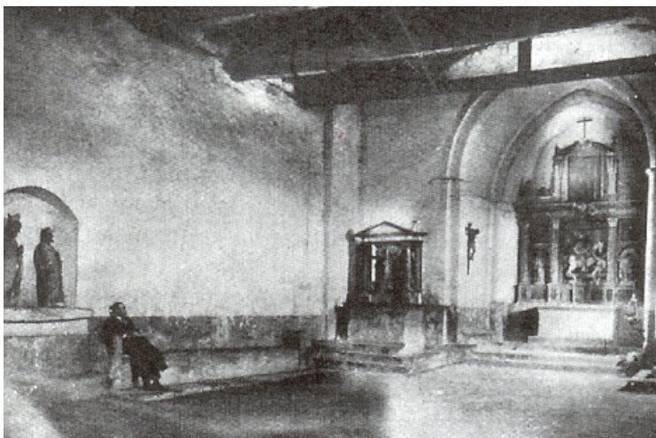
Interior de la ermita de Santa Catalina antes de la restauración.
