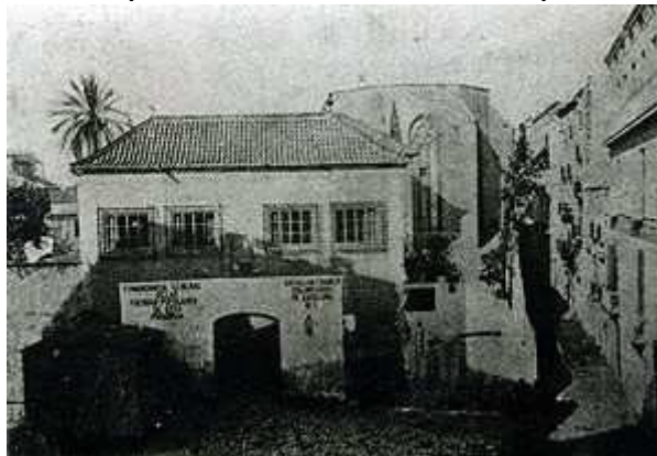
FIG. 10.1: PORTAL DEL EXMONASTERIO DE JUNQUERAS (1868. ENTRADA A LA ZONA MILITAR)
