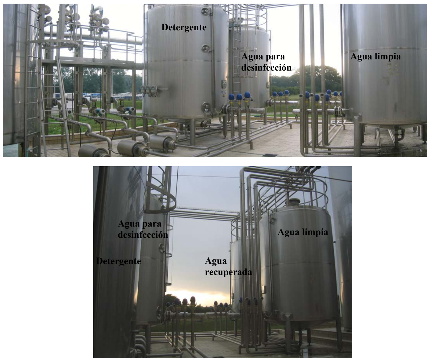
Figura 2. Fotografías de una instalación CIP real en una industria láctea. CAPSA (Granda, Siero, Asturias)
