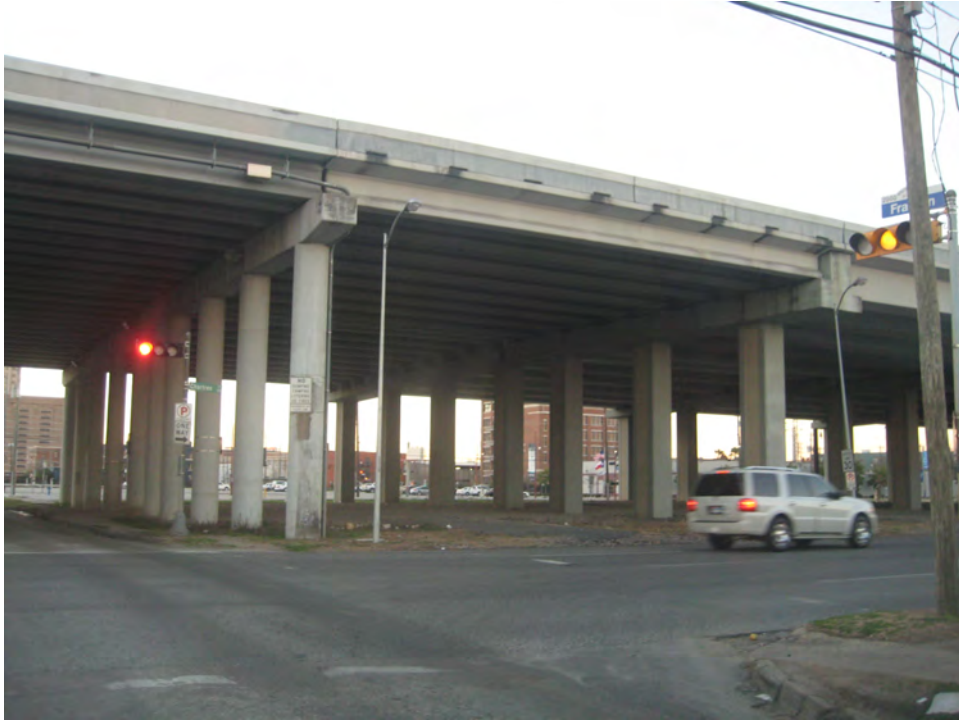
Fig. 66.- Otra vista del tramo elevado de la autopista I-59. Fuente: Autor.
