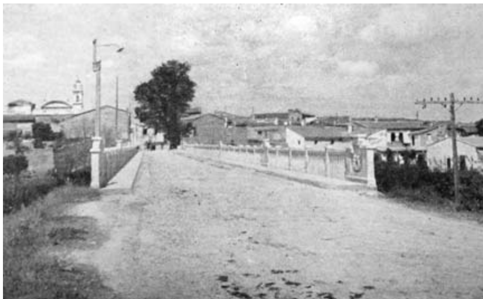
Fig. 5-31: Pont per sobre del barranc de Picassent i lloc de passeig. Llibre de Festes de Picassent, 1949. Fons: AMP.
