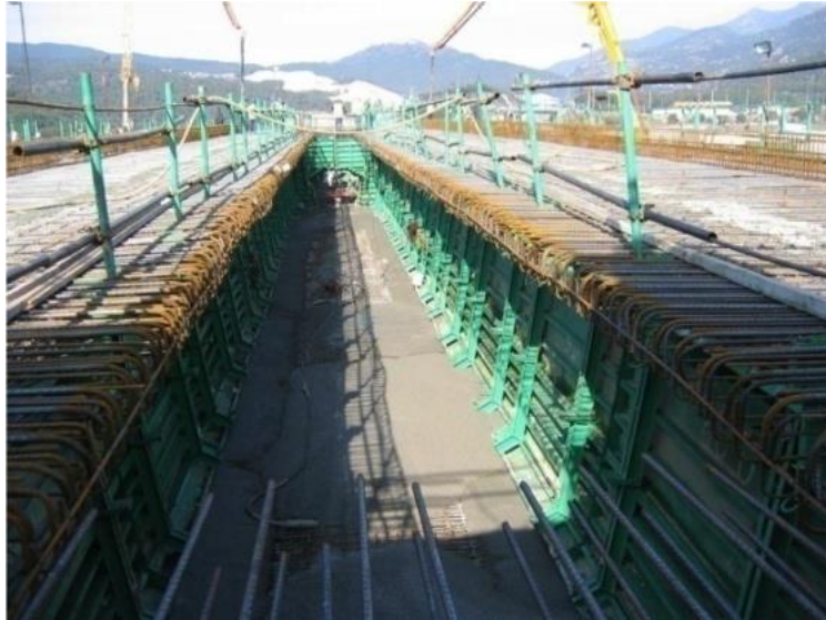
Figura 2.4.4. Loop joints con longitud de solape según normativa y encofrado interior.
