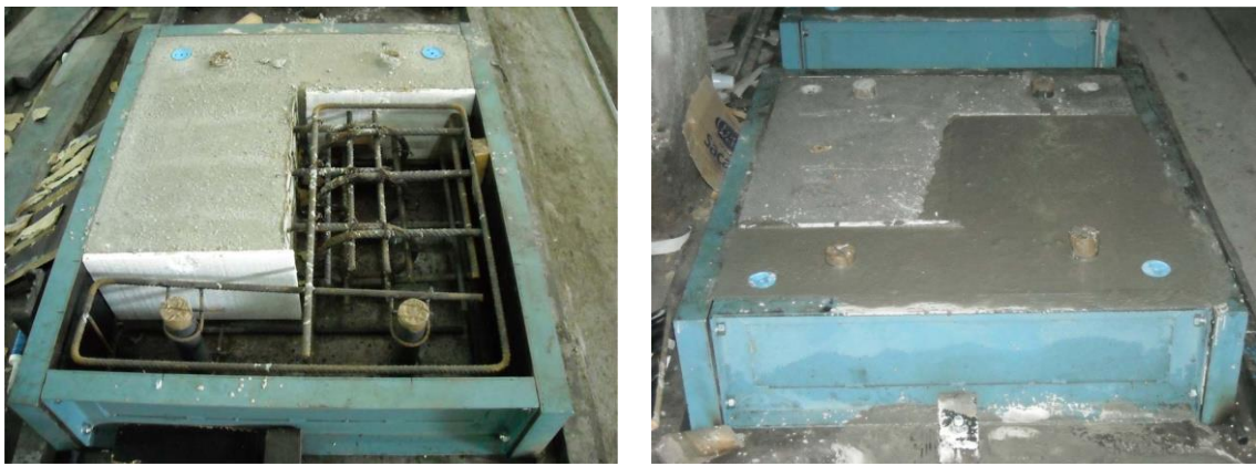
Figura 5.2.1.5. Fases de hormigonado de los paneles.
