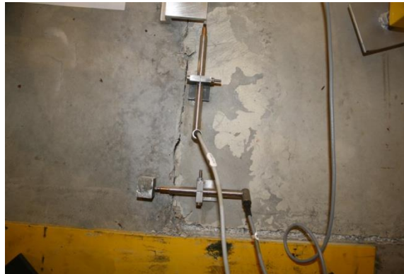
Figura 5.2.2.6. Colocación de los LVDTs en el panel.
