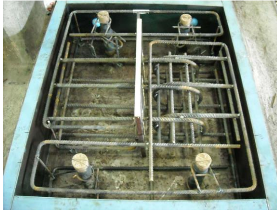
Figura 5.2.1.4. Armaduras en los paneles.
