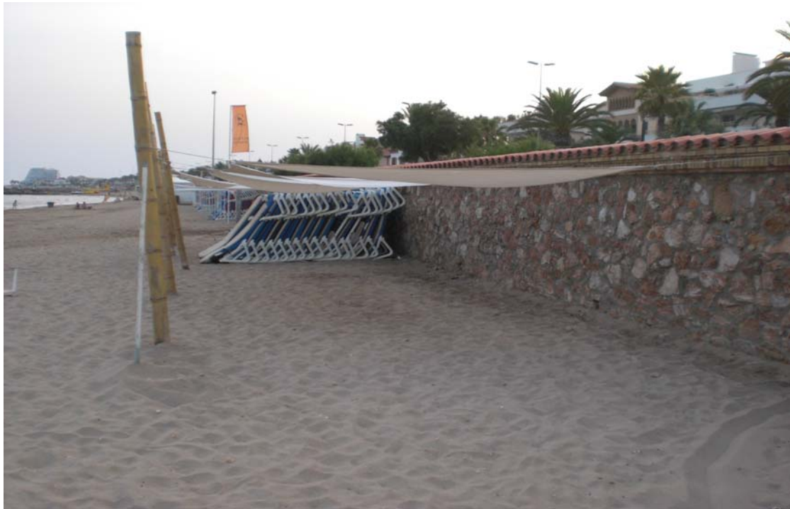
Imagen 13: Muro de la zona de cruising de Sitges playa
