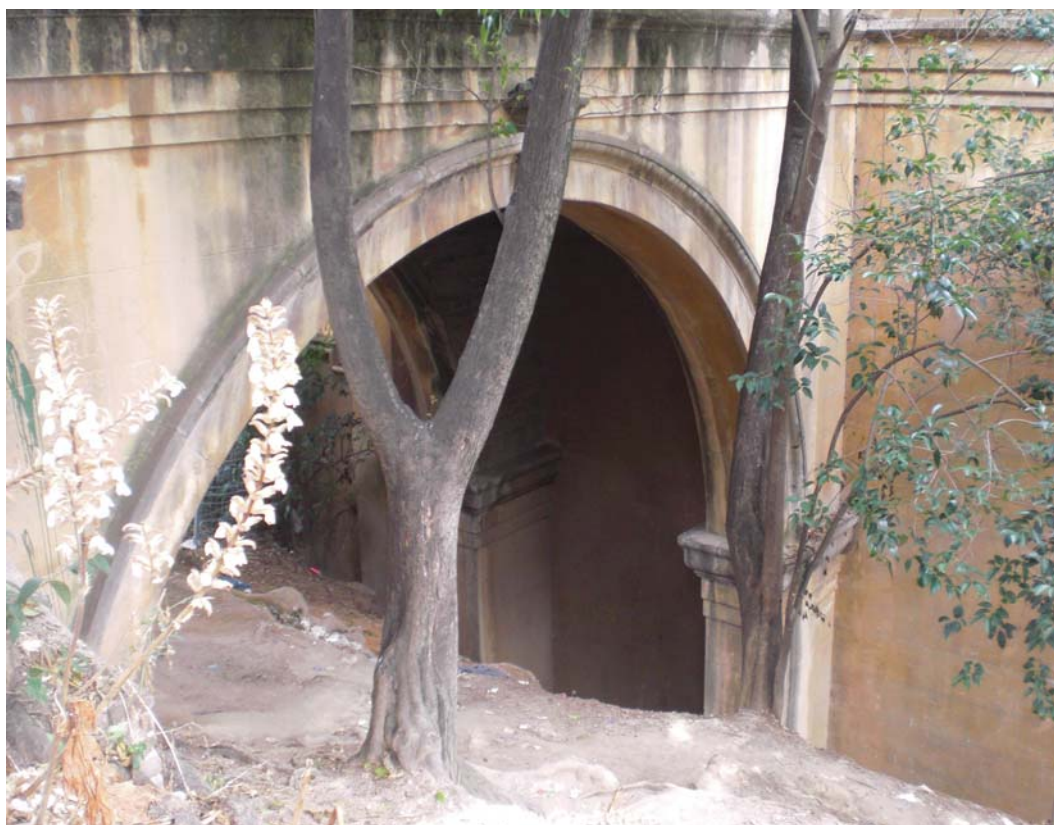
Imagen 4: Puente del palacio de Alfonso XIII
