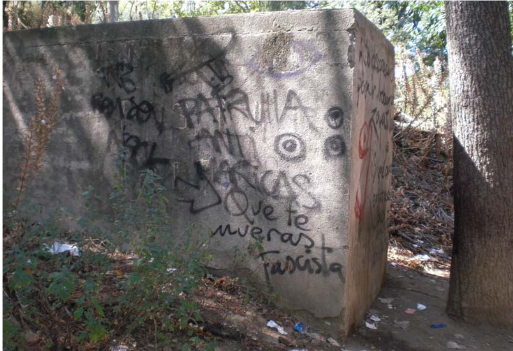
Imagen 5: Caseta del parque.
