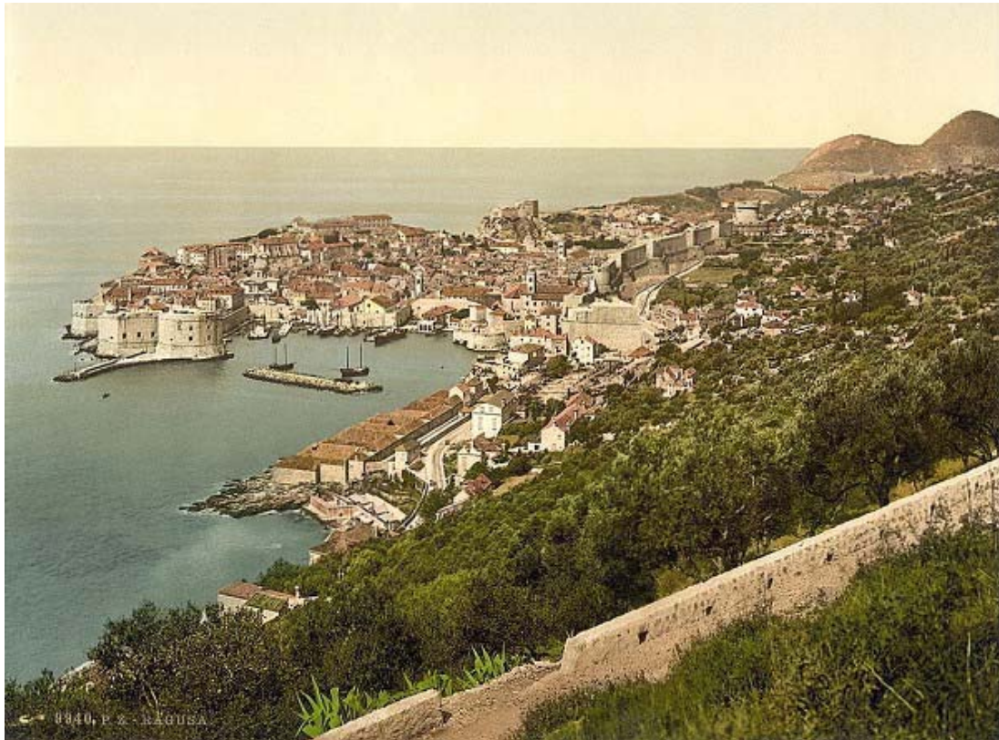
Figura 11.2 Ragusa, ca. 1890-1900. En Views of the Austro-Hungarian Empire . Detroit: Detroit Publishing Company, 1905 (LOC, Prints and Photographs Division, n. "9940"). Se puede apreciar el amplio edificio del lazareto de la Porta Plozze en la entrada del puerto
