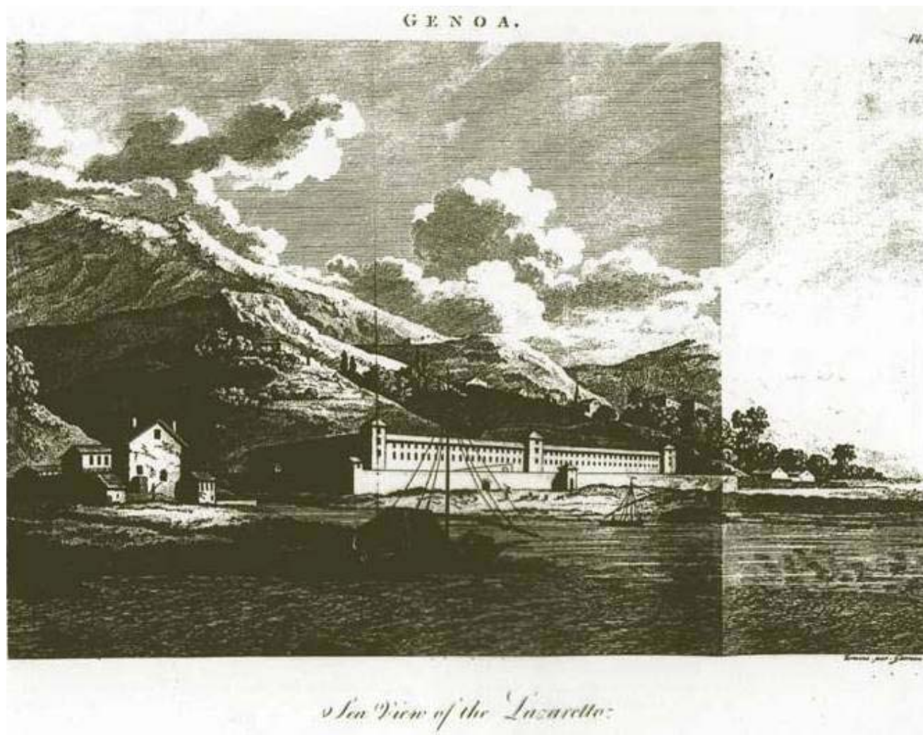
Figura I.84 Genoa. Sea View of the lazaretto, sección, elevación y planta, finales del siglo XVIII. En Howard, John. An Account of the Principal Lazarettos in Europe... Warrington: William Eyres Publishers, 1789, plancha 1
