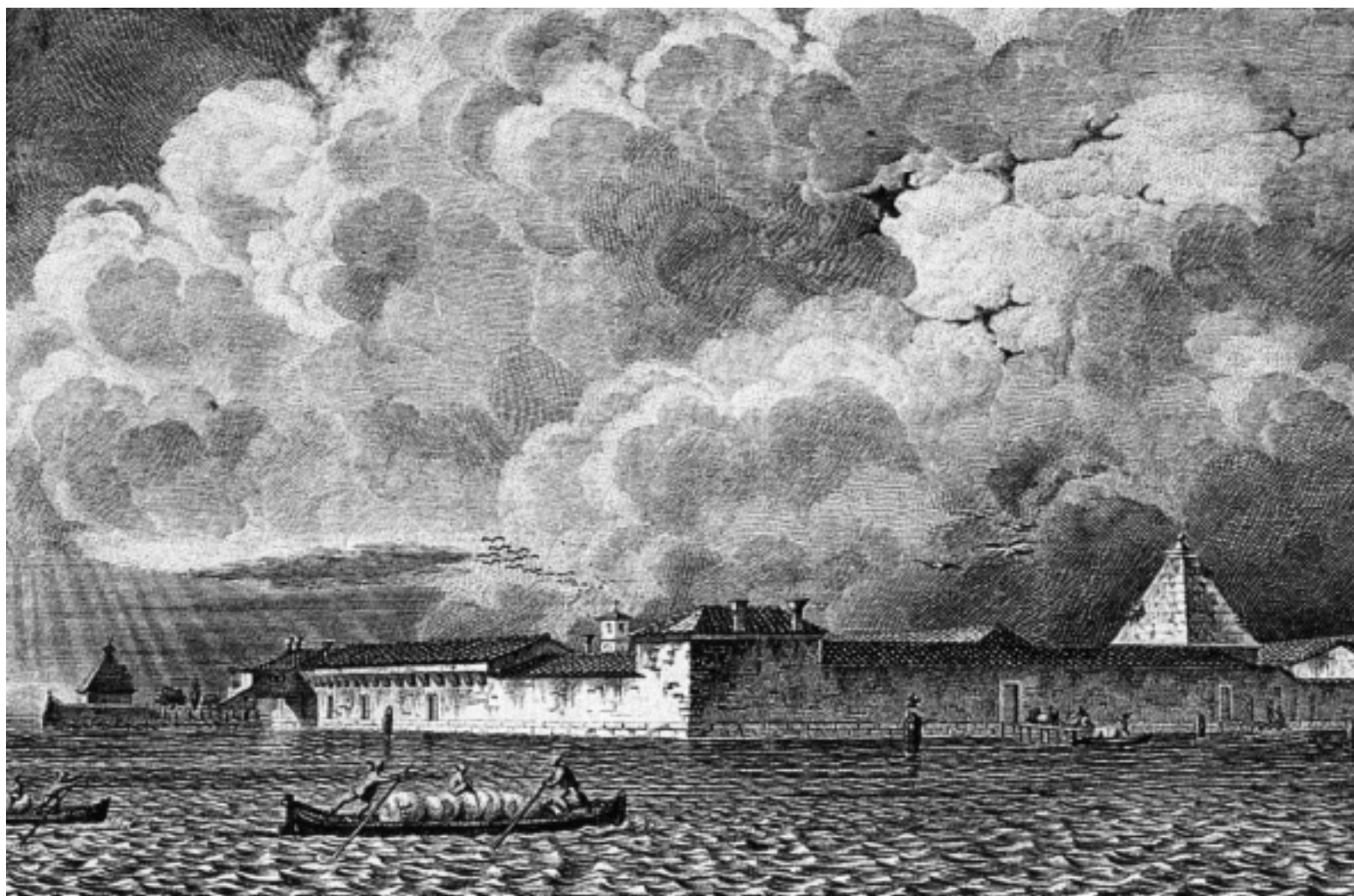
Figura I.81 Il Lazzaretto Vecchio (Venecia), vista. Sitti pittoreschi e prospettive delle lagune venete. Venezia: 1838, n° 6
