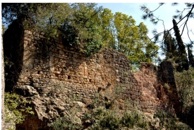
Fig. 2: Antiques restes de les estructures del Castell de Cabrera, al nord de les construccions actuals. Vista de la façana est.
