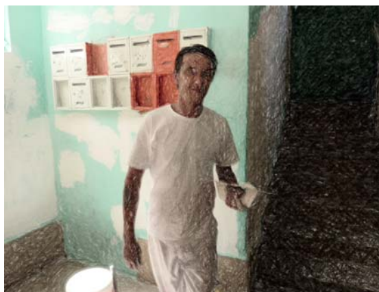
imagen 4. Obras de rehabilitación de los edificios de La Milagrosa.
