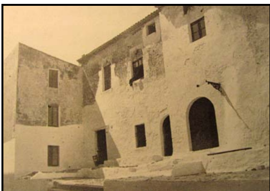
Imatge 13. Fotografia de la plaça de Sant Joan abans de convertir-se en el Palau Maricel (1905) 31 . Imatge extreta: Arquitectura de Sitges 1800-1930 . Ed. Ajuntament de Sitges. Sitges. 2001. Pàg. 178.
