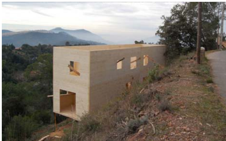
Figura 7.6. Imatge de la construcció de la casa 205 (Basulto, 2014) Fotografia: Starp Estudi
