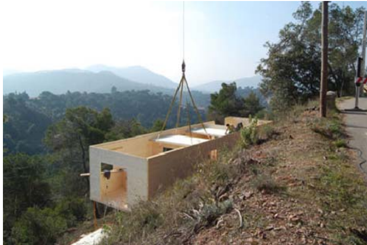
Figura 7.5. Imatge de la construcció de la casa 205 ((Basulto, 2014) Fotografia: Starp Estudi
