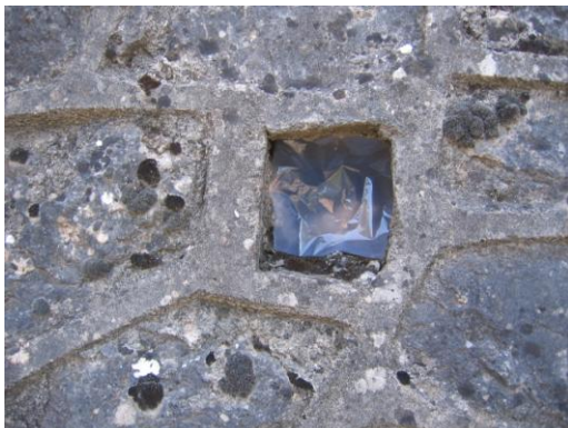
Agujero de roca con cemento (Mallorca)
