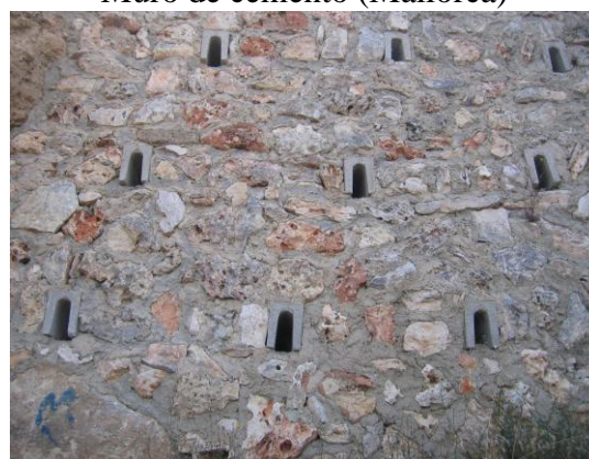
Muro de piedra con cemento (Mallorca)
