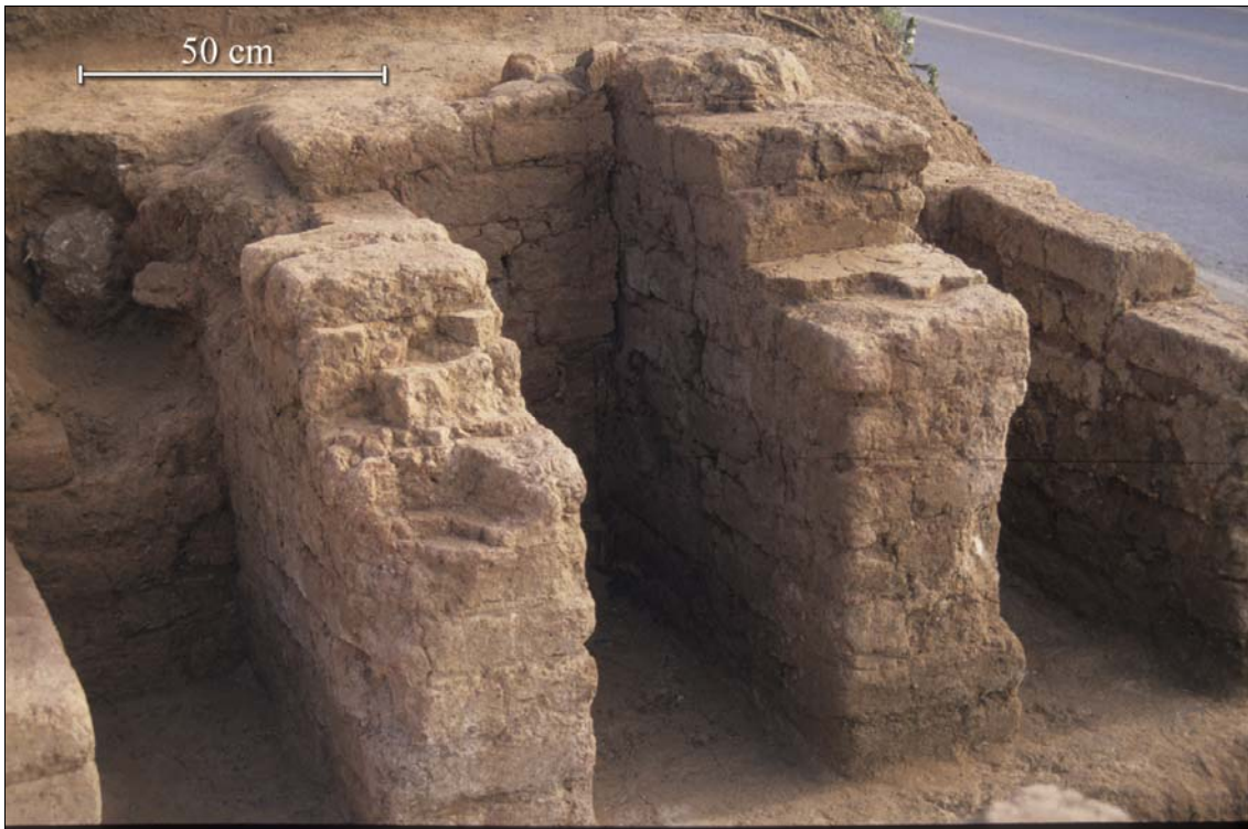
Figura 12. Detall de dos arrencaments d'arc del forn de Can Notxa (A partir de Rigo 1996: Annex de diapositives).
