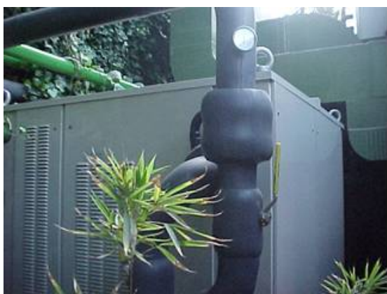
Imatge 8.1 – Equip de refrigeració per absorció
