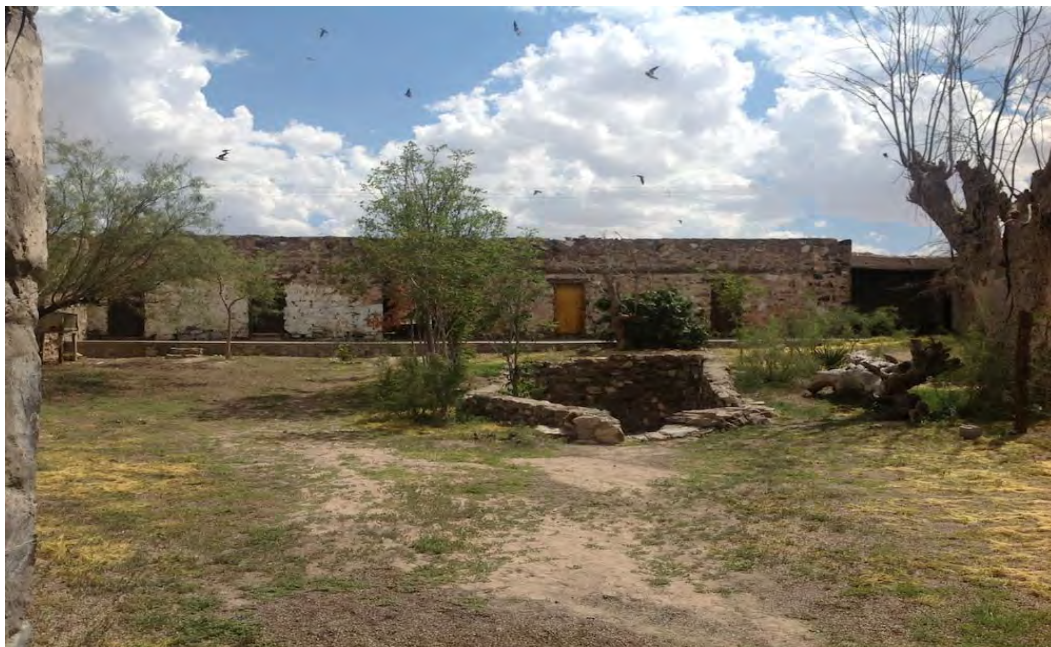
Fotografía 21 Edificios de una hacienda.
