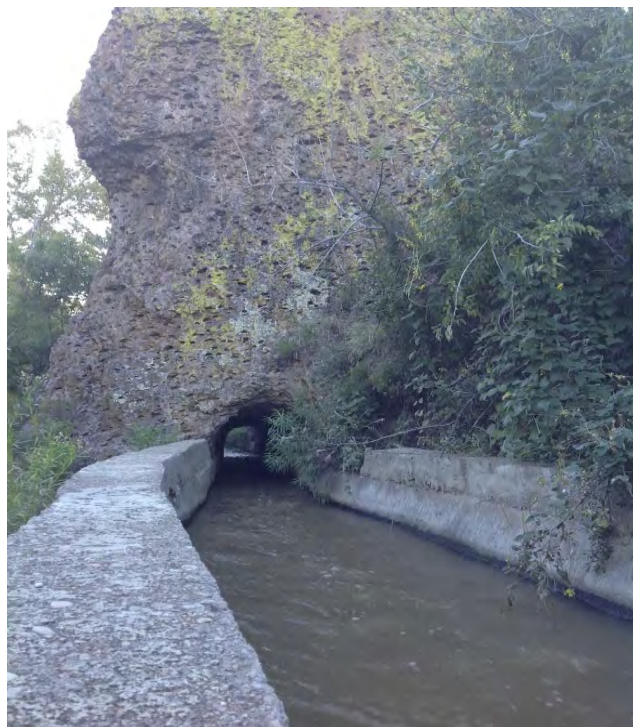
Fotografía 37 Canal de agua.
