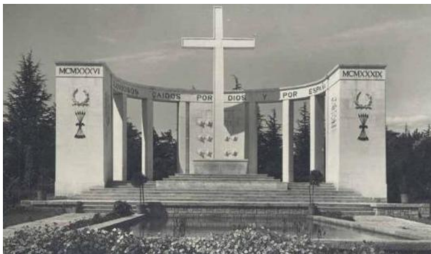
Monument "a los Caídos" de Sòria
