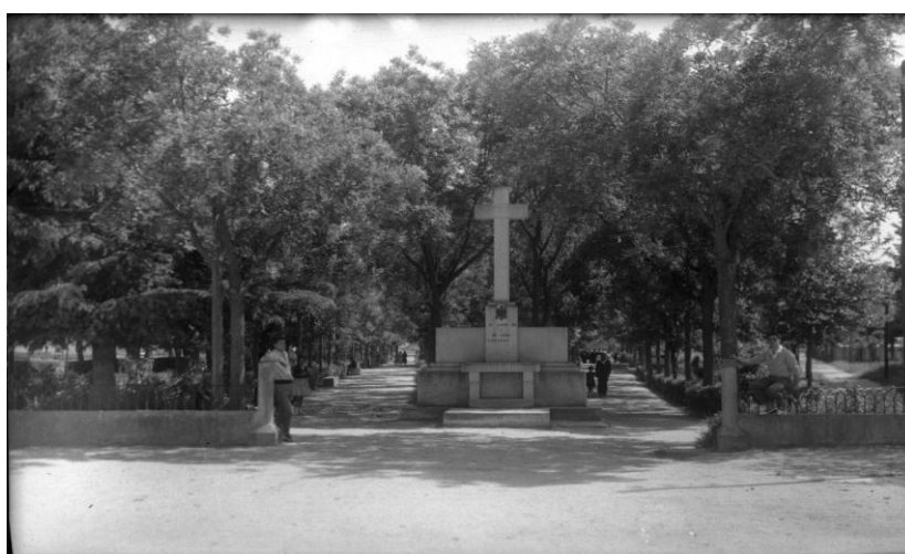
Monument a los "caídos" d'Arévalo (Àvila)
