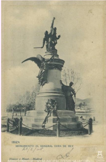
186. Monumento al General Vara de Rey. Autor desconegut, 1905
