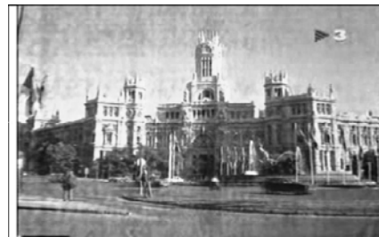
Fig. 4. Edificio de telecomunicaciones en Madrid (7:58).
