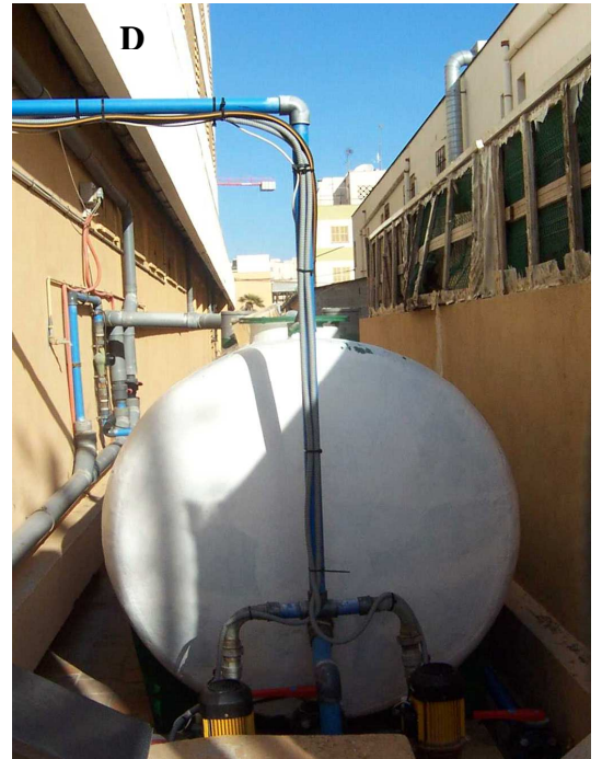
Figura 1.4. Elementos del sistema de reutilización: (A) las bombas impulsoras; (B) los depósitos de la terraza; (C) los filtros a limpiar; y (D) el depósito colector.
