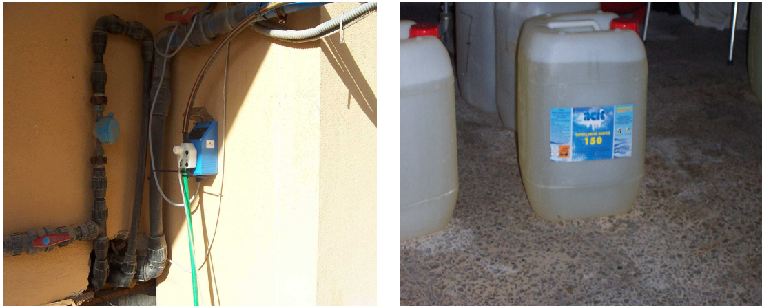
Figura 1.6. El dosificador y el bidón de hipoclorito.
