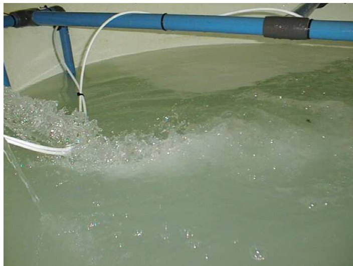
Figura 1.13. Aspecto del agua gris en el depósito de recirculación.
