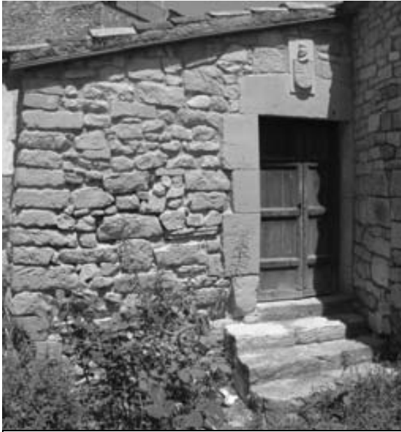
Fotografia de l'entrada de la casa Miró, ubicada a la part de l'hort del monestir.
