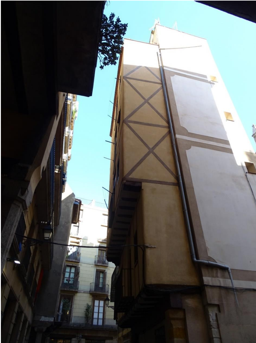
Fig. 188. Ejemplo de Bolada todavía existente en un edificio frente a Santa María del Mar. Fuente CR POLIS Universitat de Barcelona
