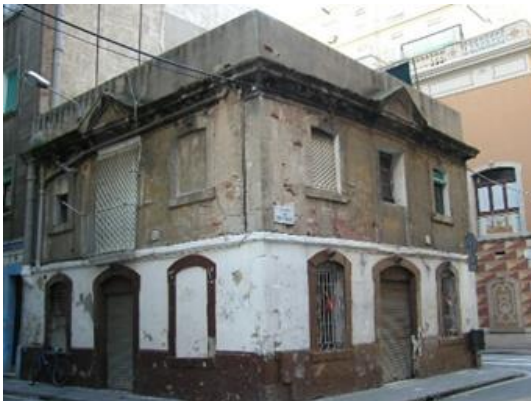
Fig. 186. Una de las pocas casas originales (1761) existentes al inicio del s.XXI. Se puede observar el paramento que substituye el tejado a dos aguas original, por un terrado. De una vivienda se pasa a, como mínimo dos, con la entrada d'escala en la calle posterior. Fuente CR POLIS Universitat de Barcelona.
