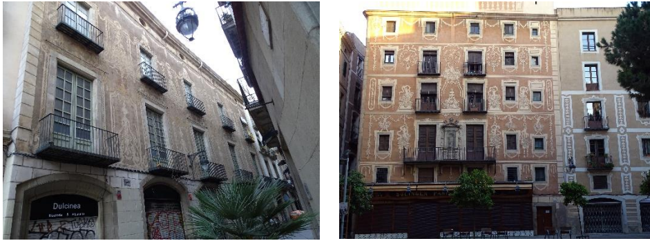
Fig. 191. Dos imágenes de fachada de casas en las que no sólo se aprecian los balcones, sino también el tratamiento de “esgrafiado” de las fachadas
