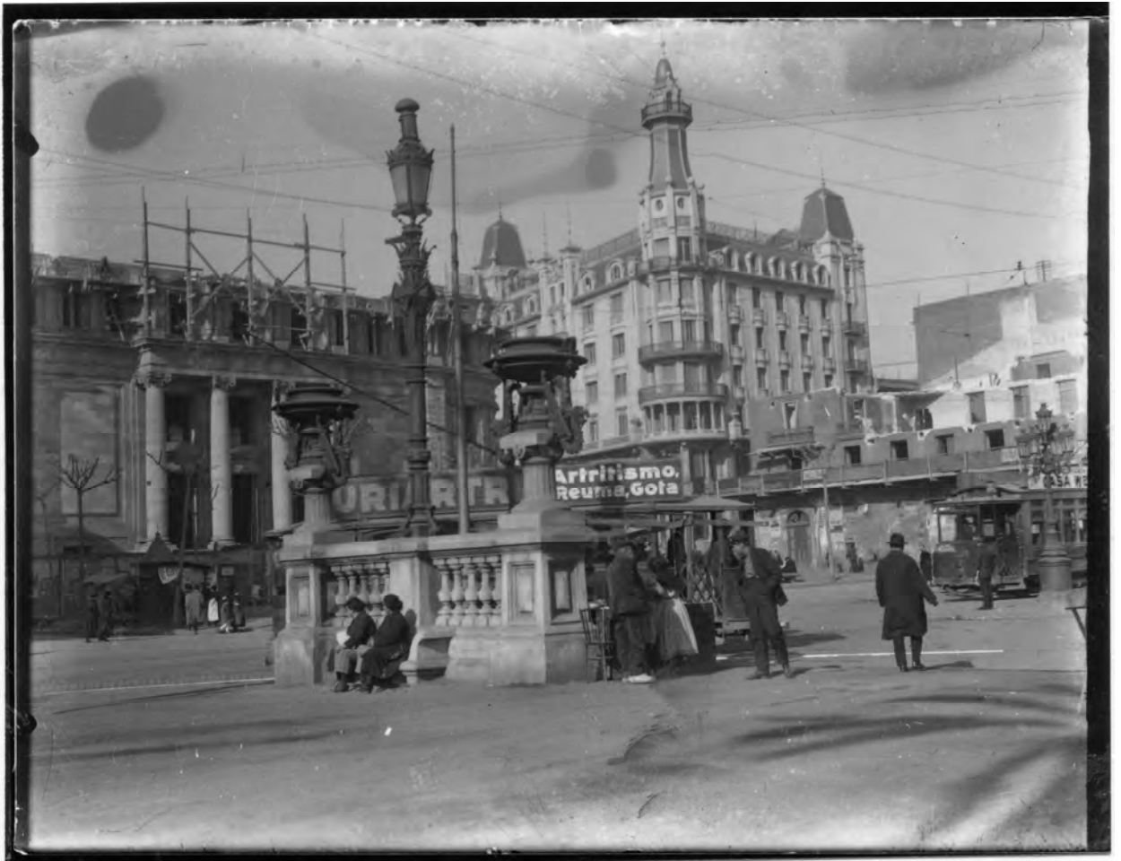
Derribo del Convento de San Sebastián.
