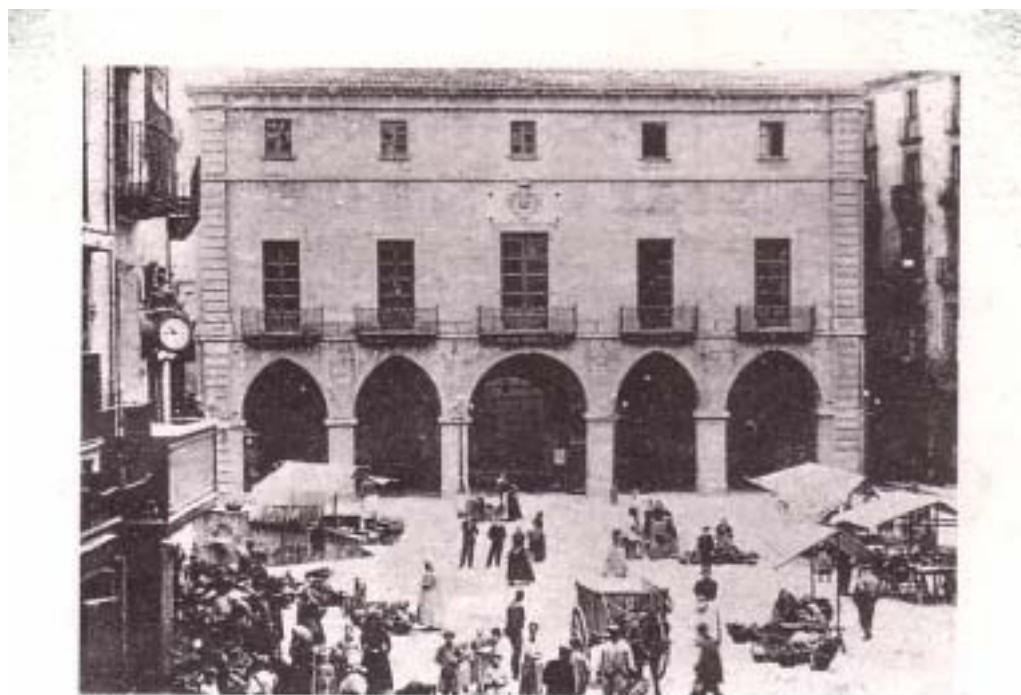
Edifici de l'Ajuntament de Manresa. Fotografia de l'any 1895 51 .
