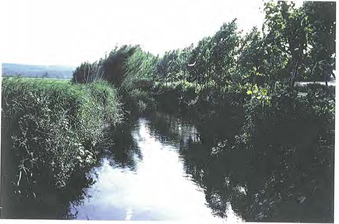
El canal del marquès de Sentmenat
