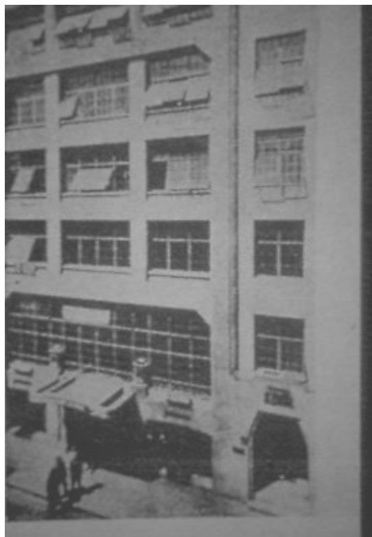
Edificio Santacilia. 1925. Carlos Obregón. Fuente: De Anda Alanís, Enrique. La arquitectura de la revolución mexicana , UNAM-IIIE, México, 1990, imagen 9.
