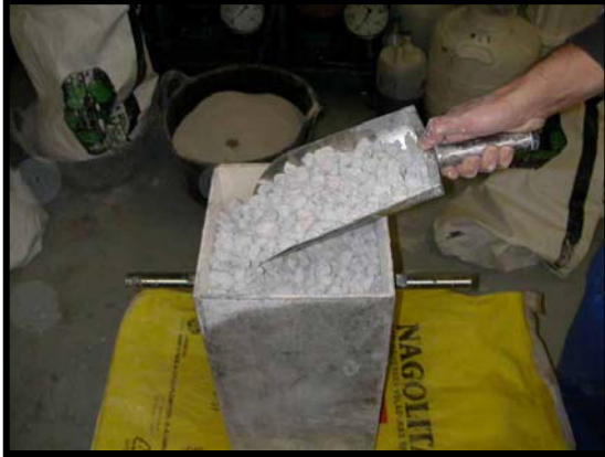
Figura 5.22.- Vertido del árido sobre el cubilote metálico
