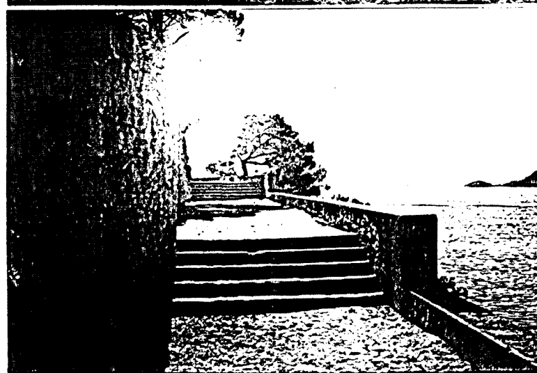
TRAM 3. Sector amb tancament interior incomplet. Foto 13, Foto 14, Foto 15.
