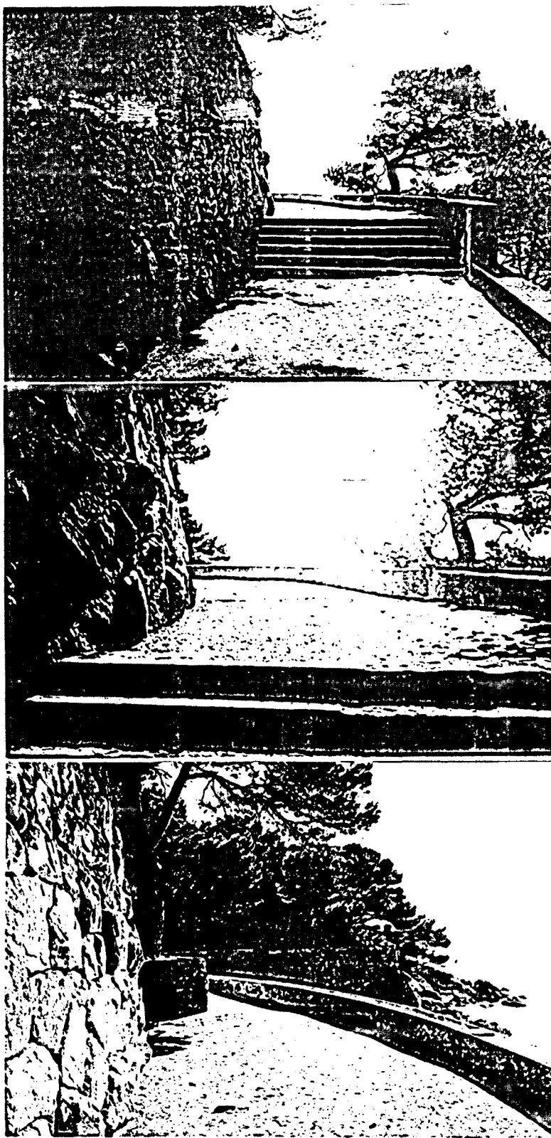
TRAM 3. Sector amb tancament interior incomplet. Foto 16, Foto 17, Foto 18.
