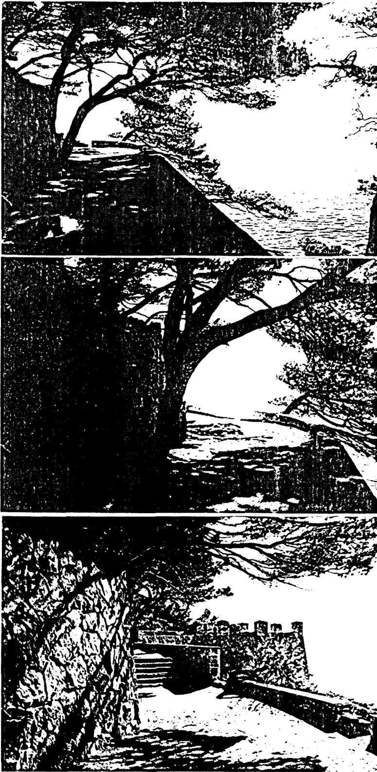
TRAM 3. Sector amb tancament interior incomplet. Foto 25, Foto 26, Foto 27.
