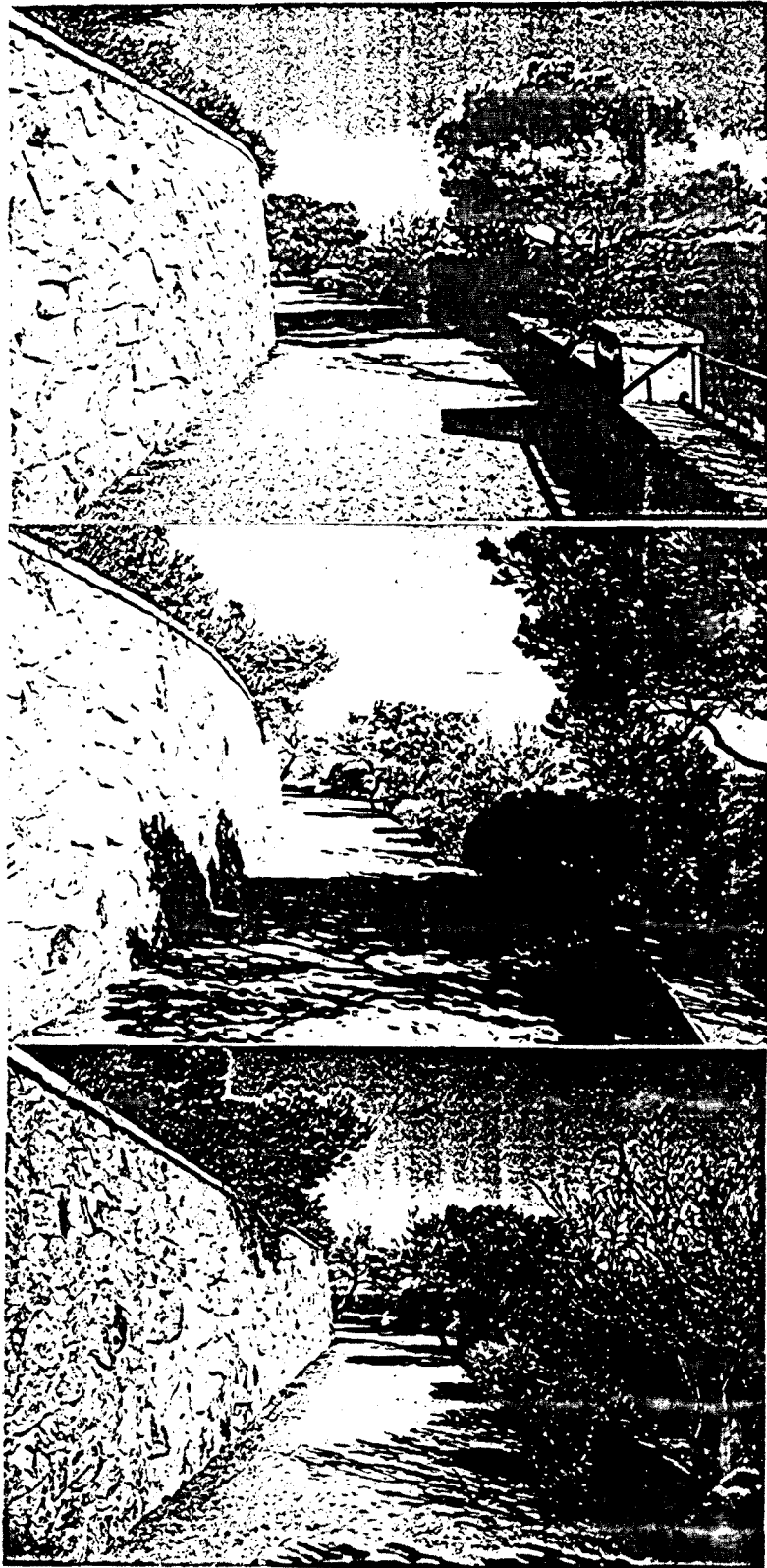
TRAM 5. Sector consolidat. Foto 46, Foto 47, Foto 48.
