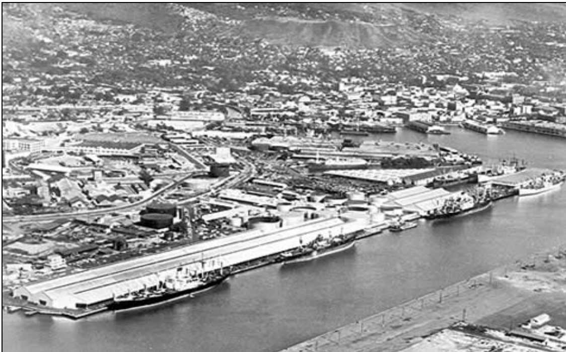
Foto 7 Muelle de operaciones para buques de carga general, buques de la línea San Francisco – Hawaii en 1948 23
