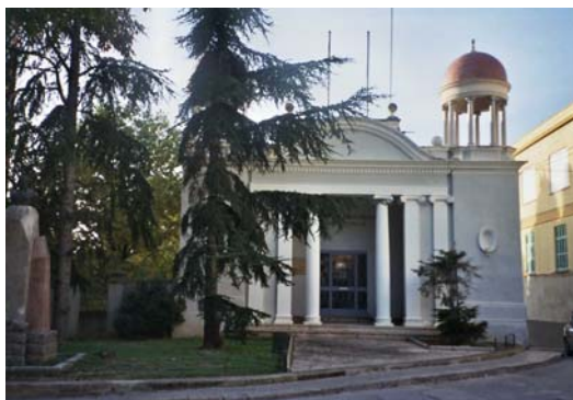
Fig. 18. Edifici de la biblioteca de Valls construït l'any 1918 (2004)
