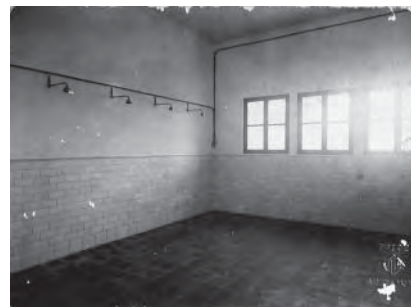
767. Escola Graduada de Montuiri, sala de dutxes. AMMo
