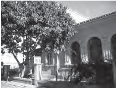
340. Escola Graduada de tres seccions i una sala de treballs manuals a Manacor. Estat actual, façana lateral
