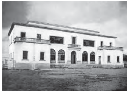
464. Escola Graduada de nins a Muro. Façana posterior
