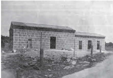
521. Escola Unitària a Sa Murtera en construcció
