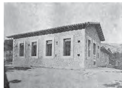
480. Escola Unitària de nines a Puigpunyent en construcció
