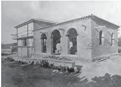
329. Grup Escolar Unitari al Pont d'Inca i Sa Cabaneta en obres
