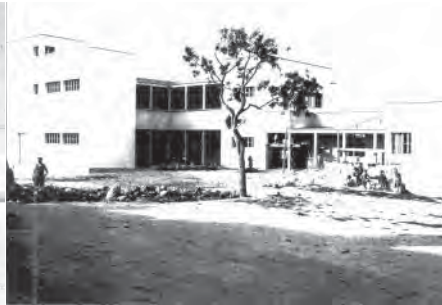
615. Grup Escolar a Son Espanyolet en construcció. 2 de maig de 1934. AAM
