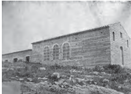
408. Escola mixta de S'Espinagar en construcció
