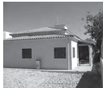
783. Escola de Sant Jordi. Estat actual
