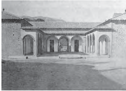
300. Escola a Bunyola encara en obres. Un pilar del porxo d'accés i el seu motllo apareixen en primer pla
