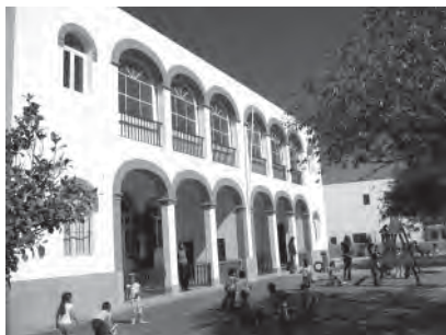
582. Grup Escolar Unitari per a nins i nines a Sant Josep. Estat actual, després de l'ampliació en alçada
