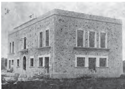
268. Escola Graduada de nins a Santanyí. L'edifici en construcció
