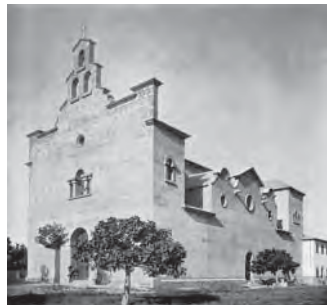
97. Església del Molinar. Obres iniciades el 1924
