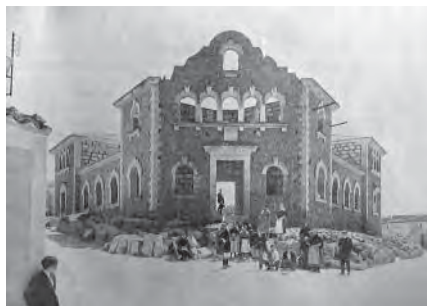
560. Escola de Sineu en obres
