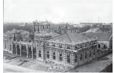
135. L'Escola Graduada de Llevant de Palma en construcció. 1912. AMPa
