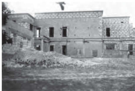
759. Escola Graduada de Montuïri en construcció. COA
