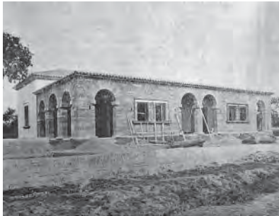
312. Grup Escolar Unitari al Pla de Na Tesa en construcció
