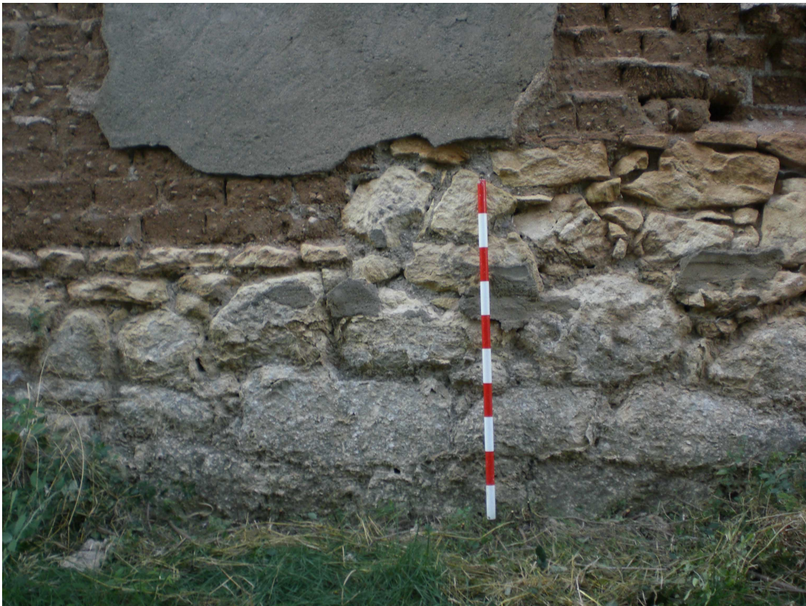
Fig. 3.3.4 Fonaments d'una masia de possible origen andalusí. Fotografia pròpia.
