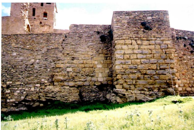
Fig. 3.5.7 Muralles d'Àger. Fotografia pròpia.
