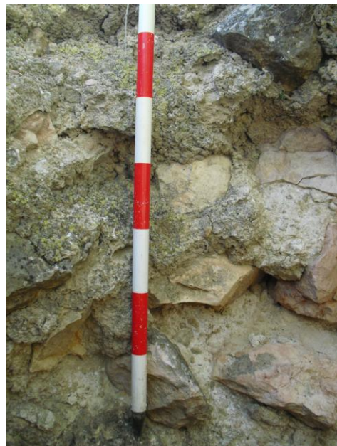
Fig. 3.5.33 Detall del mur de la torre/talaià del Tossal Gros. Fotografia pròpia.
