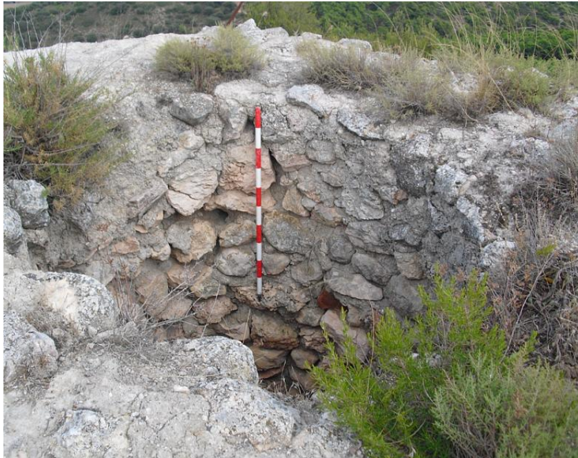
Fig. 3.5.30 Mur de la torre/talaia andalusina de Campvim. Fotografia pròpia.
