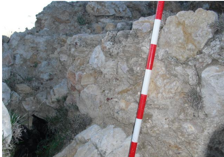
Fig. 3.5.26 Detall del mur associat a la torre. Fotografia pròpia.
