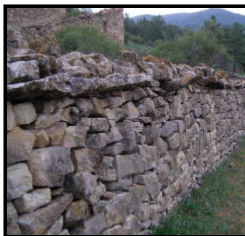
Figura 2.5. Muro construido contra el ataque de lobos (Cinc Torres; Castelló) (Foto: A. Solé)
