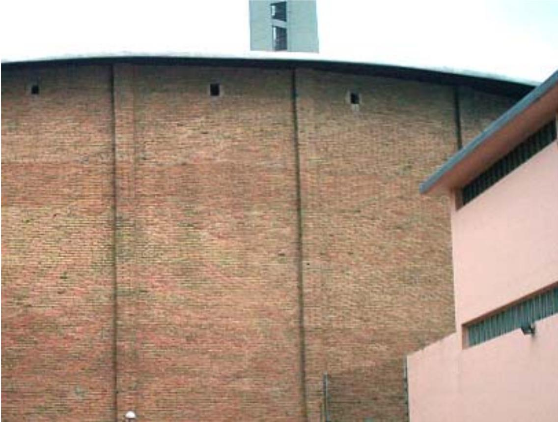
*Pilastras cerámicas que recogen la lámina de hormigón armado de la cubierta*
