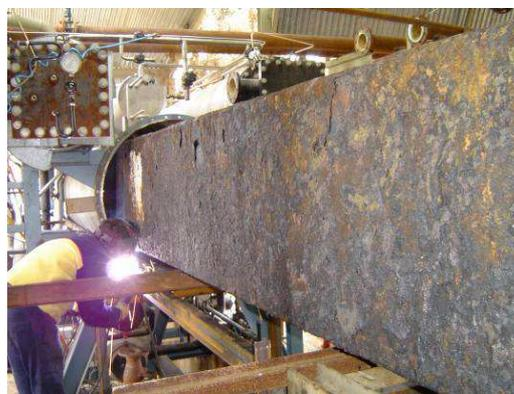
Figura 4.14 Extracción de los haces de tubos del evaporador y absorbedor
