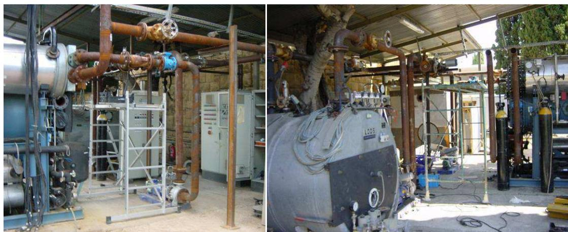
Figura 4.3 Montaje e instalación de la caldera de alta temperatura.
