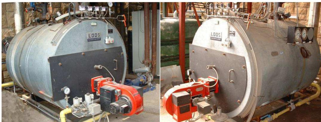
Figura 4.5 Caldera para alta temperatura marca LOOS tipo UHH.
