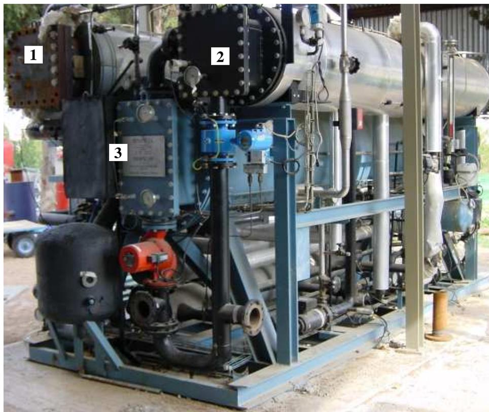
Figura 1.7 Fotografía del equipo en la que se aprecian los conjuntos de alta presión G2/C2 [1], media presión G1/C1 [2] y de baja presión E0/A0 [3].
