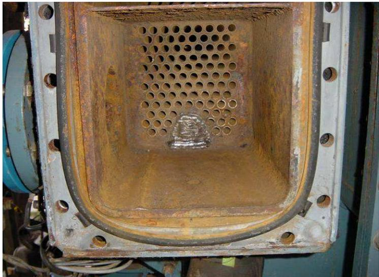
Figura 4.12 Obturación mediante soldadura del tubo del evaporador fisurado
