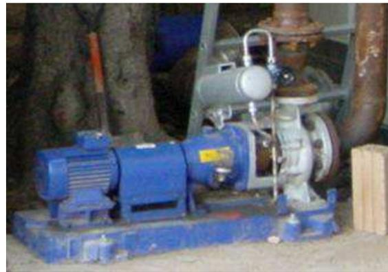
Figura 4.4 Bomba de impulsión de agua a alta temperatura, marca KSB.
