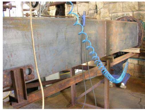
Figura 4.16 Montaje de la cuba nueva del evaporador
