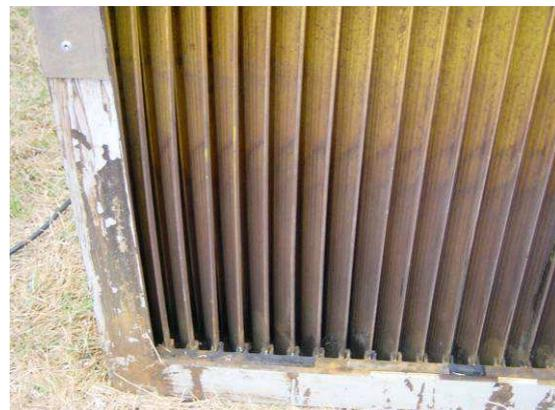
Figura 4.17 Panel separador de gotas ubicado entre evaporador y absorbedor
