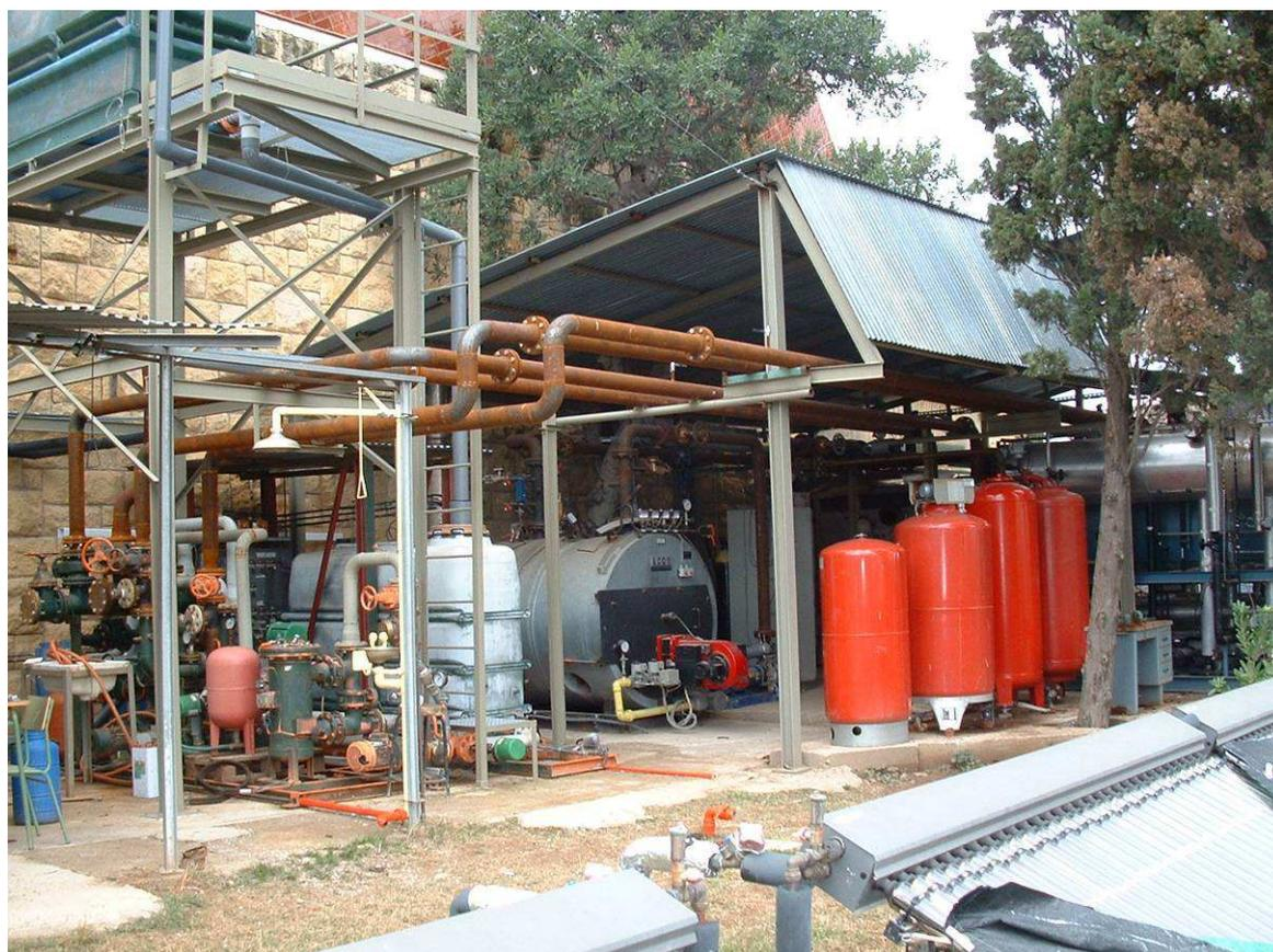
Figura 4.7 Fotografía del conjunto: Torre de enfriamiento, caldera, planta solar y máquina de doble etapa.
