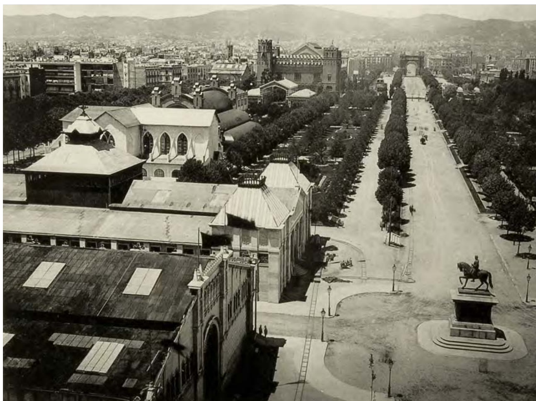
Pau AUDOUARD, Vista parcial presa des d'una torra del Palau de la Indústria, 1888. BC.
