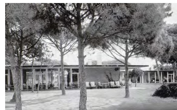
[3.19] Edificio principal del Real Club de Golf El Prat, 1958. (Autor desconocido, en Cuadernos de Arquitectura nº31)
