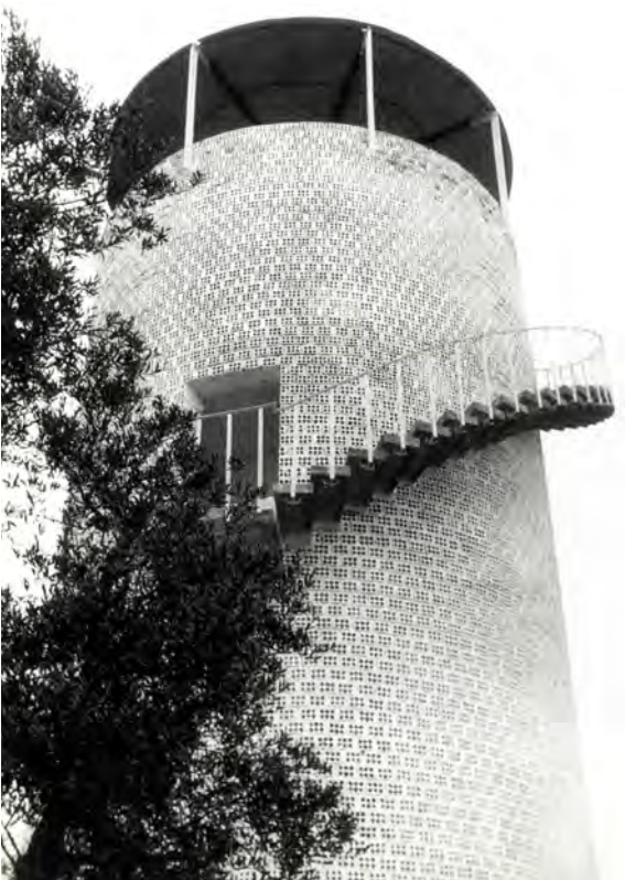
[3.26] Vista del depósito de aguas, años 1960-70. (Autor desconocido, en (COAC, 2000:74))
