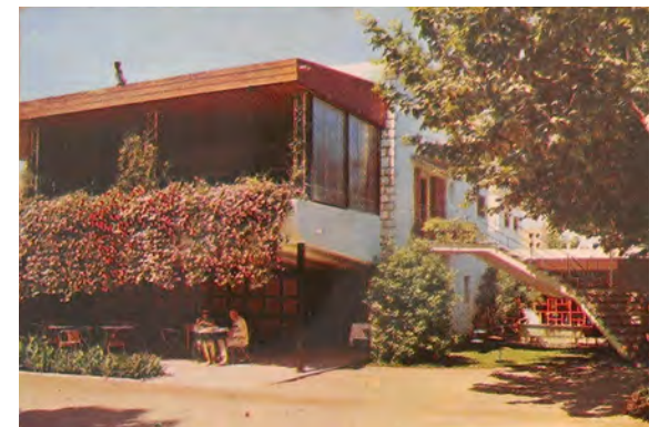
[4.29] Vista exterior de las terrazas del Restaurante, en planta baja y primera, años 1960. (Postal, Foto Raymond, en Archivo Histórico de Tarragona)
