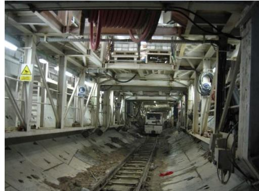
Imágenes del tren con un vagón plano para el transporte de material, y/o de personal, de una de las tuneladoras EPB (Earth Pressure Balance) de la Línea 9 del metro de Barcelona. Fotos IEM
