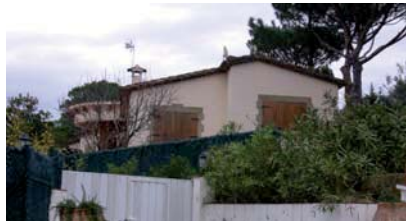
114-Xalet Junquer - Urbanització Golf Club Costa Brava de Santa Cristina d’Aro (1972). Foto plànol del fons Claret (reg. COAC 10246) i fotos de l’estat actual
