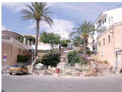
77-Escalinata – Alaior (1951) Foto plànol del fons Claret (reg. COAC 10080) i fotos de l'estat actual
