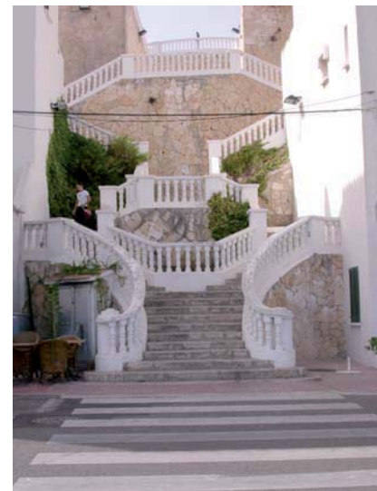
78-Escalinata - Maó (1955) Fotos plànols del fons Claret (reg. COAC 1660) i foto de l'estat actual
