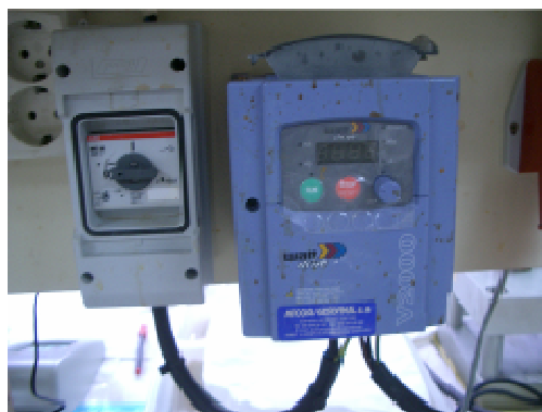
Figura 4.11. Regulador de frecuencia de la bomba HIDRA CELL.
