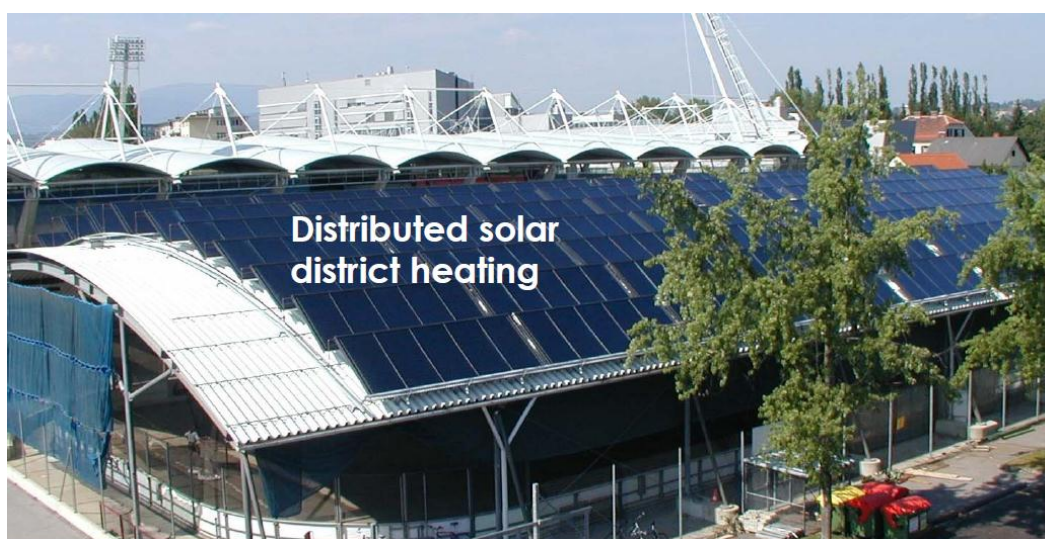
Figura 5-15. Sistema solar térmico distribuido conectado a red de distribución de calor en Graz, Austria (Dalenbäck, 2010).
