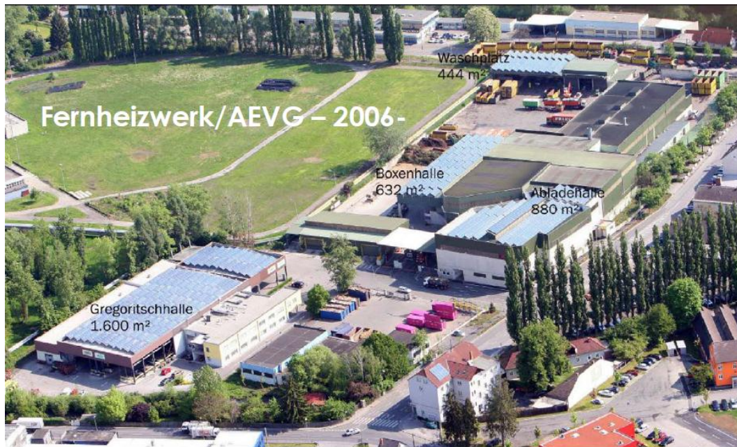
Figura 5-16. Sistema solar térmico distribuido conectado a red de distribución de calor en Graz, Austria (Dalenbäck, 2010).
