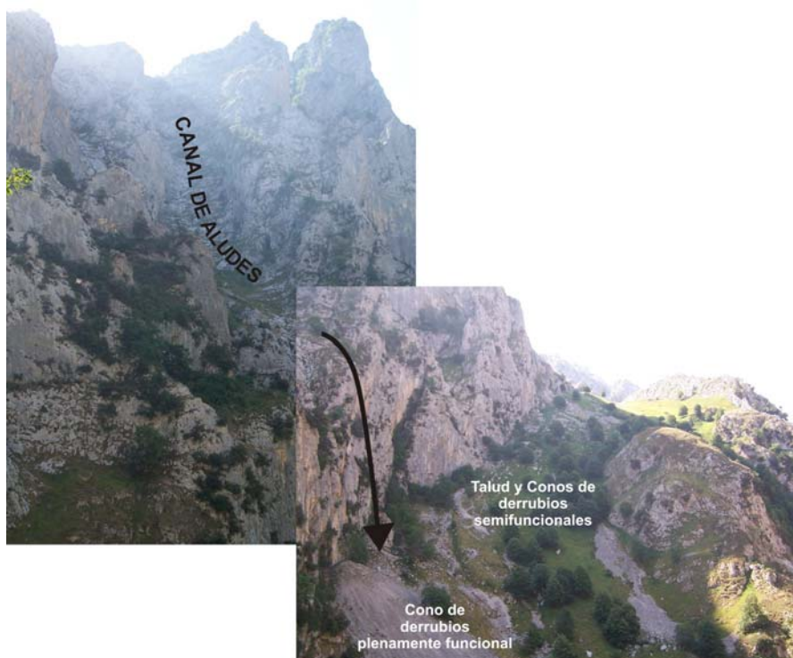
Figura 203. Pedreras activas y semiactivas en las laderas del fondo de la garganta del Cares. En estas dos imágenes se puede apreciar claramente la relación entre las grandes canales de aludes (A) y la conservación-construcción de conos de derrubios funcionales en la actualidad (B). Estos conos de derrubios aparecen desprovistos de vegetación, contrastando con los taludes y conos de derrubios próximos fitoestabilizados, formas heredadas de fases anteriores.
