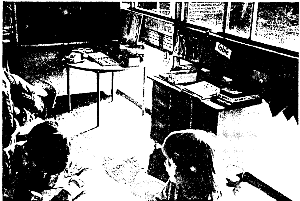
Ecole primaire Montnicolle (5 à 11 ans), Jersey. Exemple d'élément de construction tout à fait vain; il empêche l'utilisation de l'espace périphérique et, de plus, est une source de risque. La hauteur de la bande d'allège ne protège pas les vitres du mobilier. Une surface horizontale à bonne hauteur aurait été plus utile.
