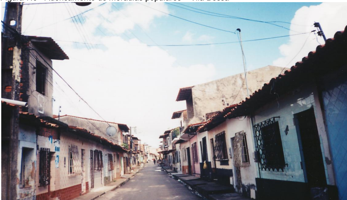
Figura 7.6 - Adensamento de moradias populares – Vila Bessa
