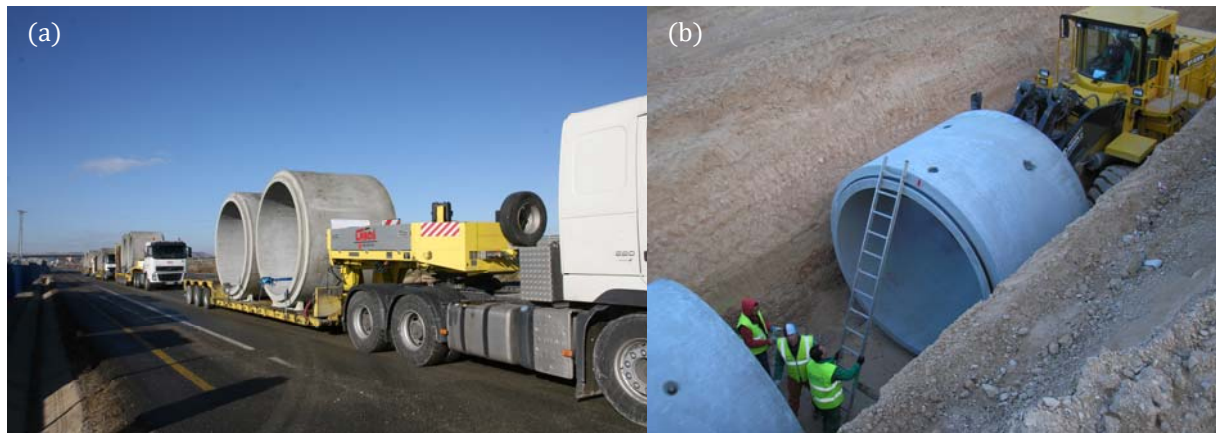
Fig. 10. (a) Transporte y (b) colocación de los tubos. Cortesía de PREFRAGA.
