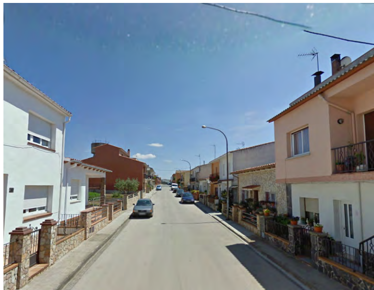
Figura 7.45. Imatge d'un eixample de baixa densitat a Mas Flassià (Vidreres, carrer de Vernet) Font: http://maps.google.es/ (data de consulta: 05/11/2011).
