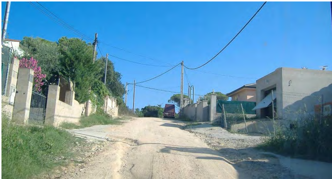
Figura 7.42. Imatge d'un carrer sense asfaltar a la Urbanització Malavella Parc (Caldes de Malavella). Font: elaboració pròpia.
