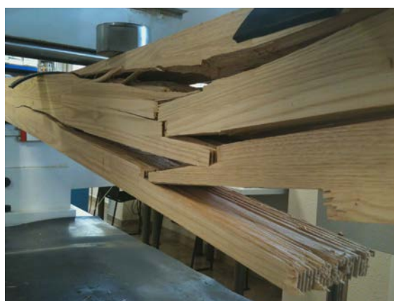
Figura 198. Biga de fusta laminada encolada desmuntada per l'esforç a flexió
