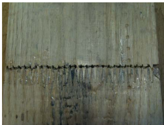
Figura 208. Unió dentada trencada completament per fusta
